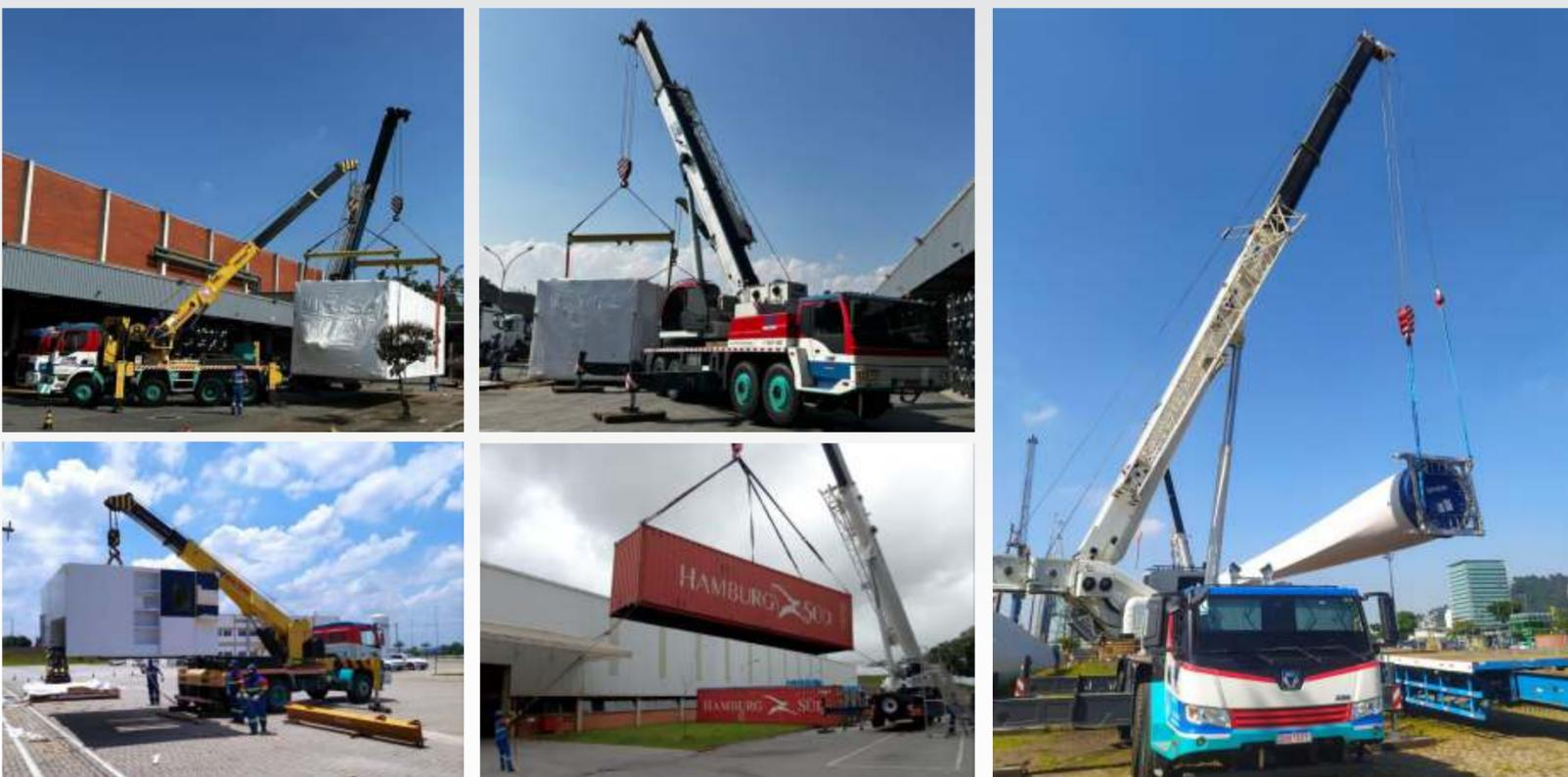
除了拆卸服务外，我们还进行起重机工作。我们对设备的可行性和尺寸进行检查，在难以进入的位置进行筒仓、储罐、塔的垂直化工作并定位机器或结构。我们有技术主管通过ART 制定Rigging计划，并且在服务执行过程中监控。
